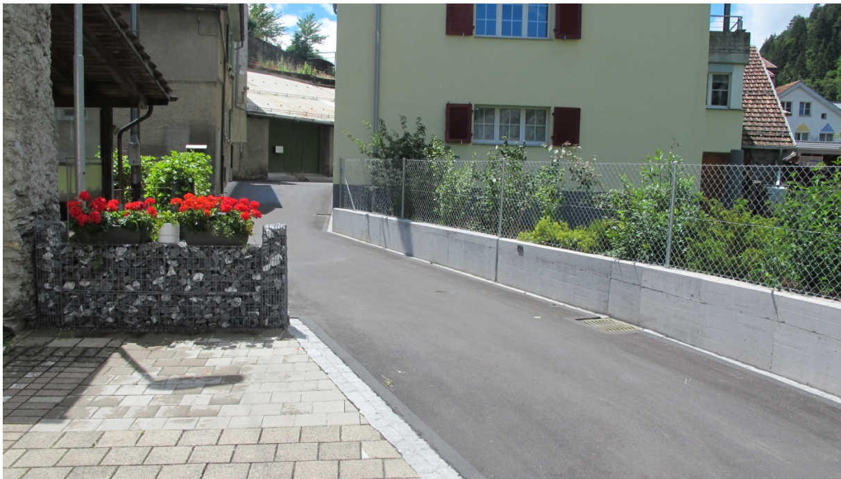
Bild Winkel nach Sanierung
