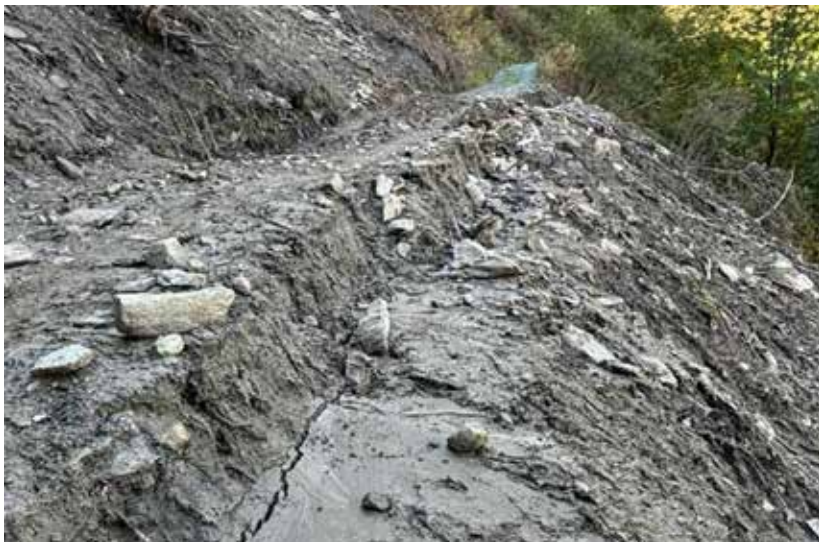
Durch Murgang mehrfach verschütteter und beschädigter Wegabschnitt zwischen der Tamboalp und dem Stäfeli.
