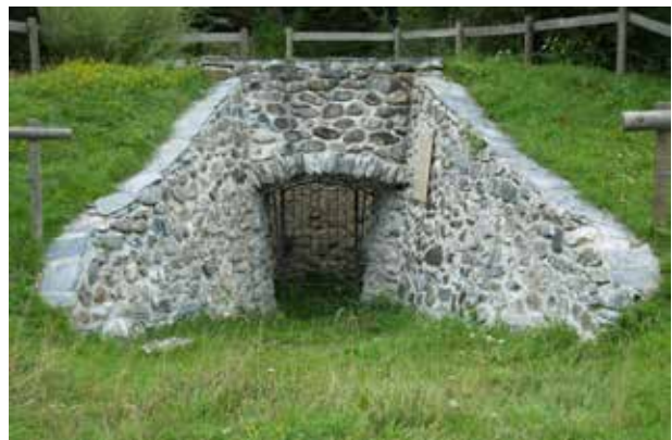
Der Arbeitsplatz des Kalkbrenners zwischen den Flügelmauern Rechts die Informationstafel mit den Ofen-Richtwerten
