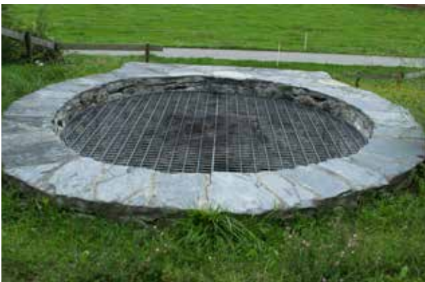
Der fertige Kalkofen mit Gitter-Abdeckung
