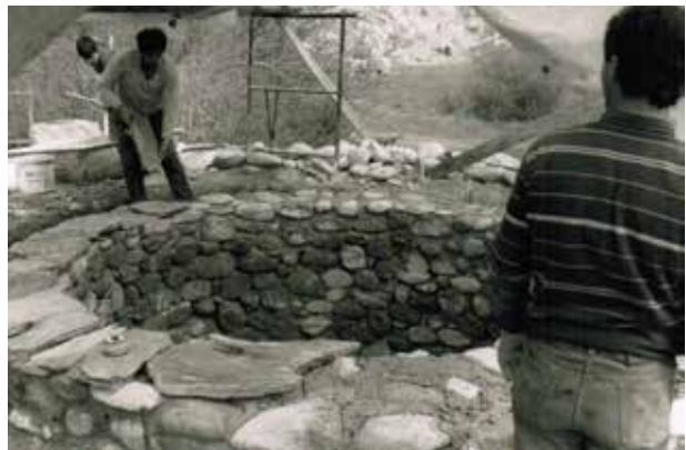
Fertigstellung des Kalkofens
