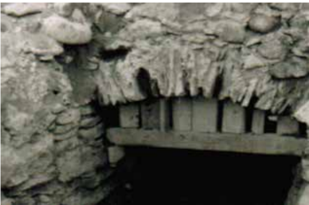
Der Gewölbebogen zum Feuerraum kommt zum Vorschein
