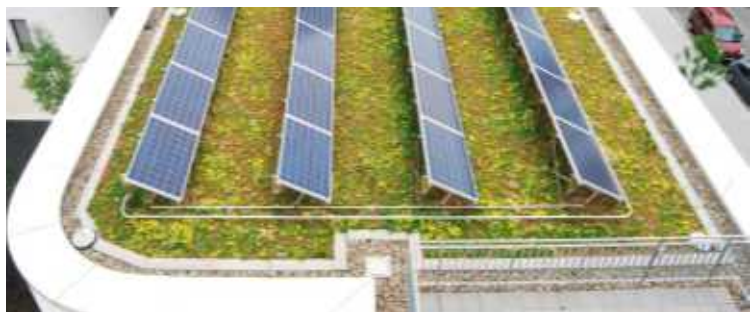
FLACHDACH MIT PV-ANLAGE UND EXTENSIVER DACHBEGRÜNUNG (BEISPIELBILD)
