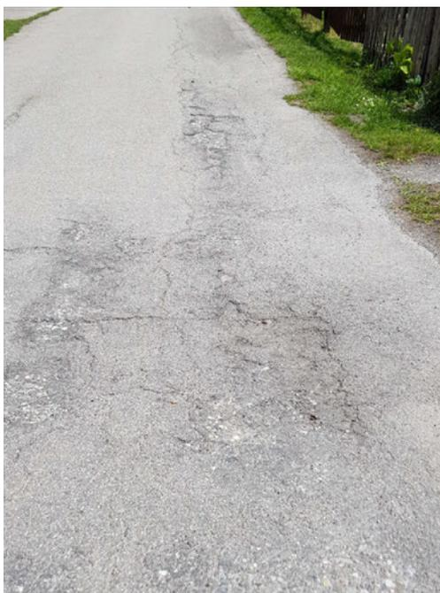
Dieser Strassenabschnitt wird zwar nicht äusserst stark frequentiert, dennoch dient er als Erschliessung für die direkt angrenzenden Parzellen sowie auch als Zufahrt zum Hofladen «Biohof Danuser». Die Entwässerung der Oberfläche erfolgt bis heute über das bestehende Quergefälle, genauer über die Strassenschulter, ins Wiesland. Dies führt punktuell zu stehendem Regenwasser (Pfützen) und im Winter zu gefährlicher Eisbildung.
