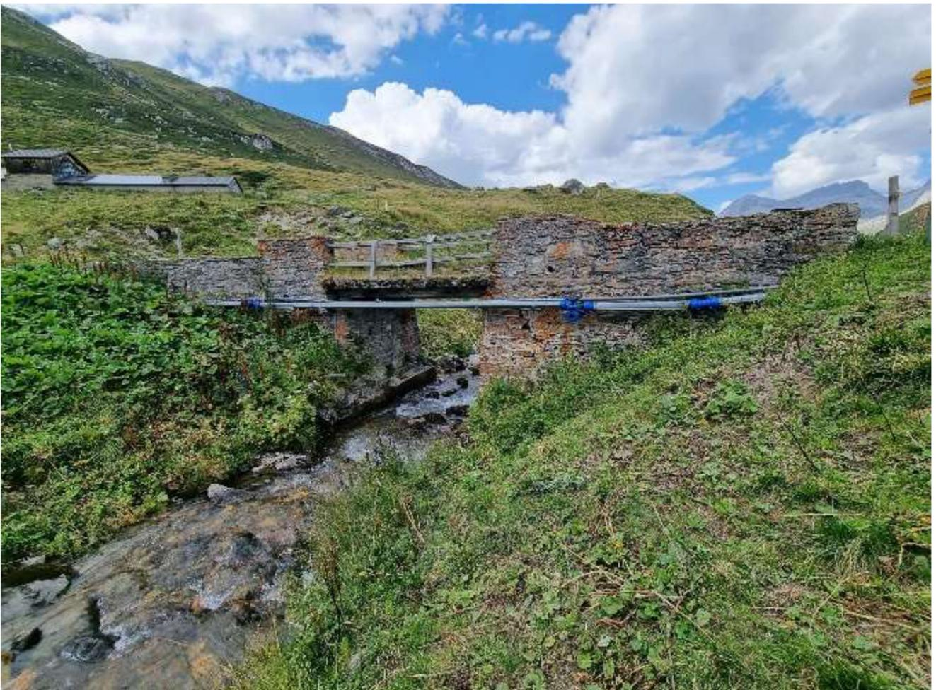
Das Primärtragwerk besteht aus sechs in Längsrichtung gespannten Rundholzträgern. Darüber liegen fahrbahnbreite, querliegende Holzträger auf. Die Holzkonstruktion ist abgedichtet und mit Erdmaterial bedeckt. Der Zustand des Holzes ist schlecht und die Tragfähigkeit kann nicht mehr gewährleistet werden.
