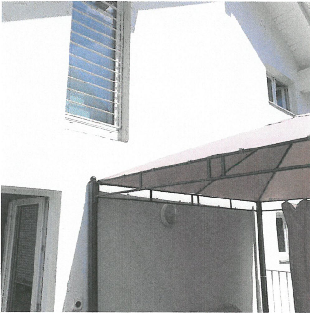
Ansicht Fassade Süd ( Balkon)
